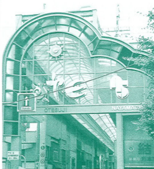
■シーズルー太陽電池の設置状況
